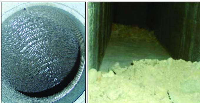
Durch die optische Inspektion werden auch verdeckte Mängel, zum Beispiel im Zuluftkanal (links) oder Aussenluftkanal (rechts), deutlich.
